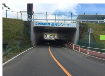
入口から直進した場合の様子
